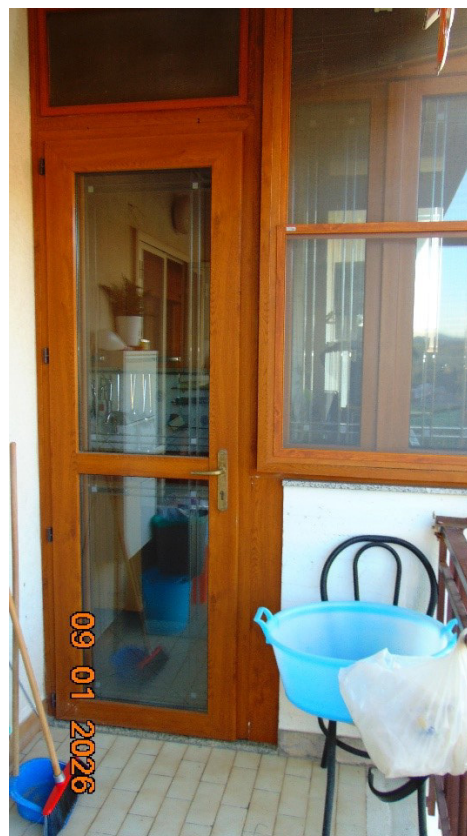
Particolare porta finestra di accesso al balcone della cucina
