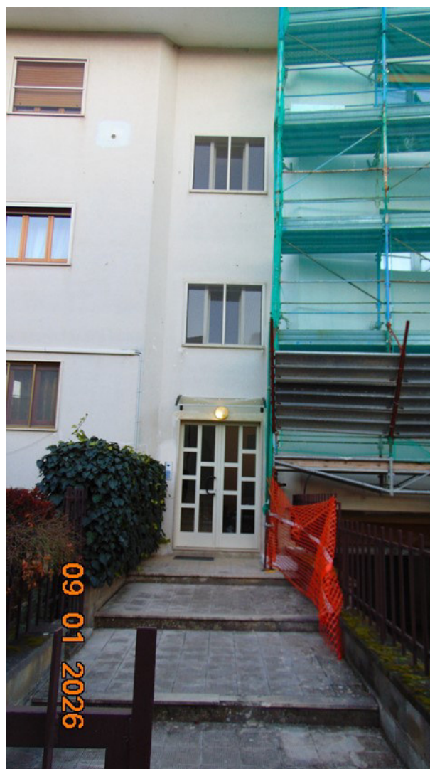
Viale pedonale verso il portone d'ingresso condominiale
