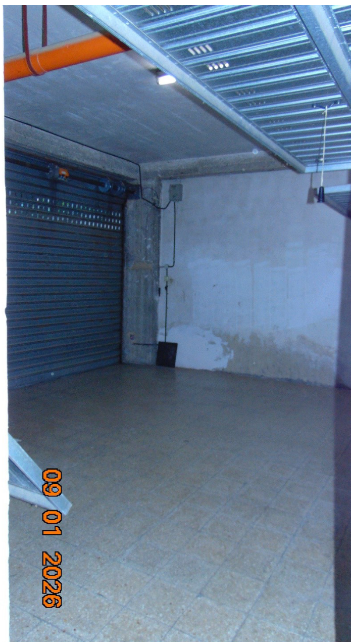
Corsia di manovra per accesso garage
