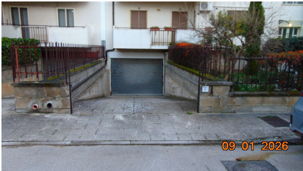
Rampa carrabile per accesso garage da strada pubblica
