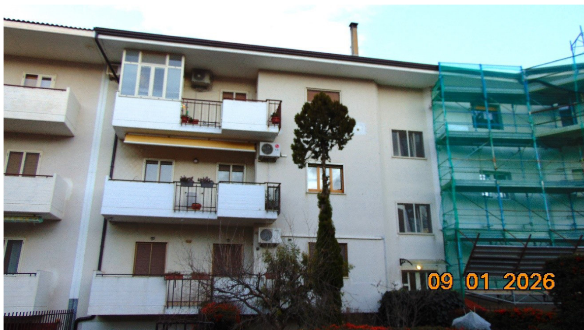
Prospetto su strada pubblica con particolare veranda
