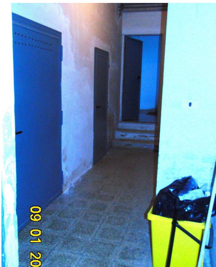
Corridoio condominiale (Piano seminterrato) per accesso vano scala
